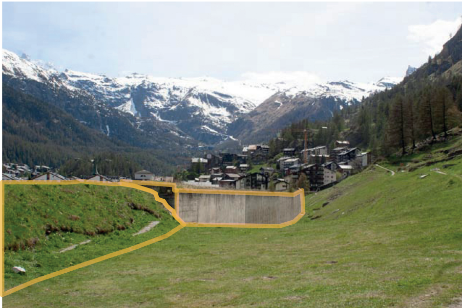
Abb. 6: Der Bahnhof Zermatt und das Gleisbett liegen geschützt hinter einer starken Betonwand und weiteren Aufschüttungen / Quelle: Eigene Abbildung
