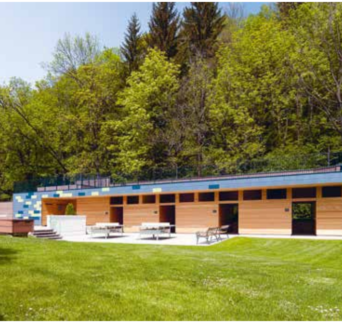
Neuer Kabinentrakt im Freibad Trofaiach
