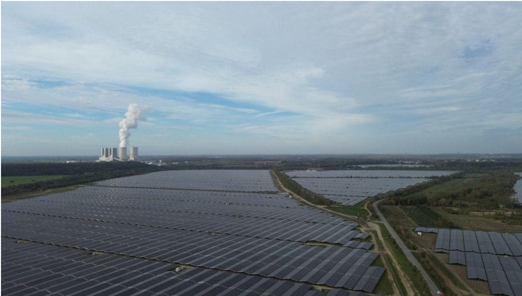
Energiepark Witznitz und Kraftwerk Lippendorf im Oktober 2024
