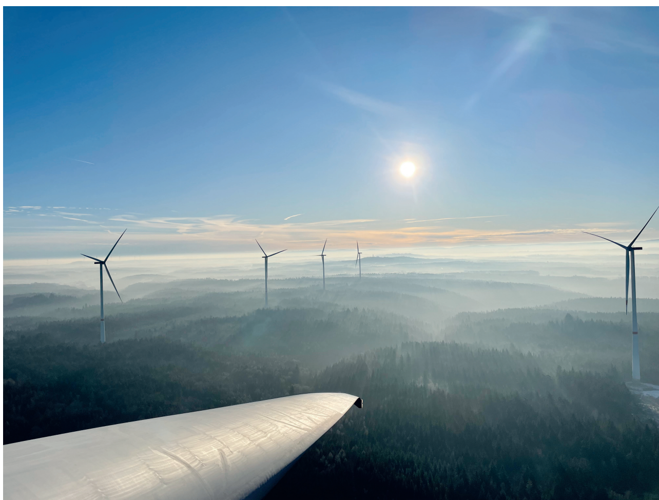
Windpark Sulzberg-Laufen / © Uhl Windkraft
