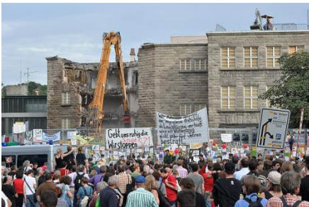
Abrissarbeiten am Nordflügel, 26.08.2010, Foto: Muscklprozz
